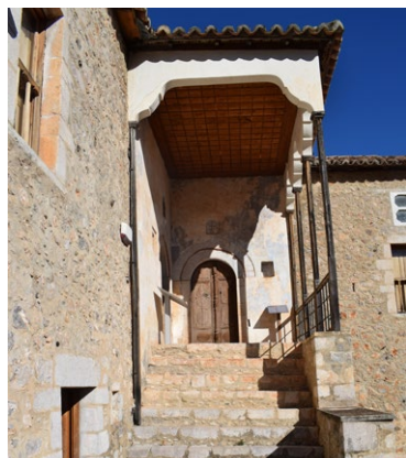
Άποψη του αρχοντικού. Σκάλες και ξουστάγι (τσακωνική λέξη: σκεπαστός εξώστης, μπροστά από την κύρια είσοδο του σπιτιού) του ορόφου. A view of the mansion. Stairs and xoustagi (Tsakonian word: covered balcony in front of the main entrance) of second floor.
